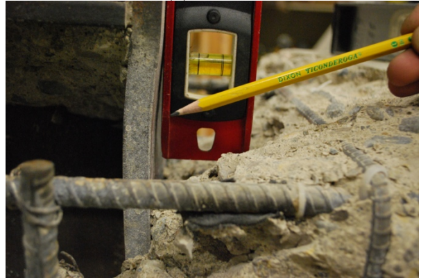
(d) Local flange bending
